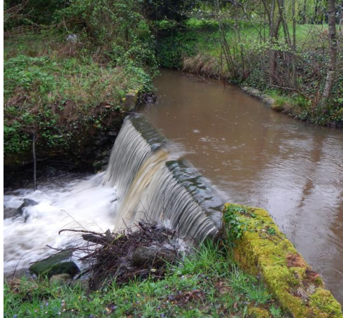
Photo avant : Chute au niveau du déversoir sur le bief du moulin (écoulement en cours forcé)
