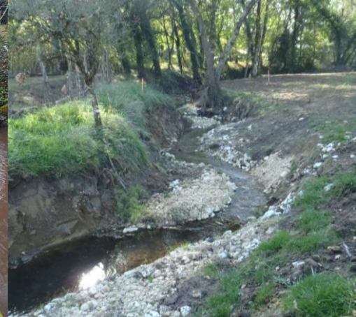
Photo après : Aménagement dans le fond de talweg
